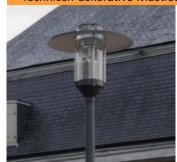
Pilzleuchten, einfach Lichtpunkthöhe 6,00m
