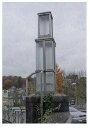
Die Lichtsäulen auf der Zubringerbrücke gehören zum geschützten Architektenentwurf. Eine lichttechnische Sanierung erfolgt unter Beibehaltung der Objektgestalt.
