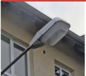
Mastaufsatz- / Mastansatzleuchten, einfach Lichtpunkthöhe ca. 3,50-8,00m
