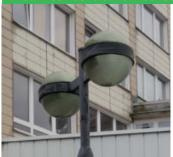
Kugelleuchten, doppelt Lichtpunkthöhe ca. 3,50m
