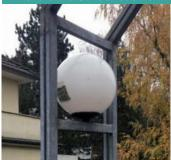
Sonderleuchte als Kugelleuchte, einfach Lichtpunkthöhe ca. 2,50m
