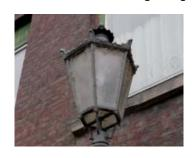
Aufgrund fehlendes IP-Schutzes sind die Leuchtenköpfe teilweise stark verschmutzt.
