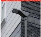
Mastaufsatz- / Mastansatzleuchten, einfach Lichtpunkthöhe ca. 5,00-8,00m
